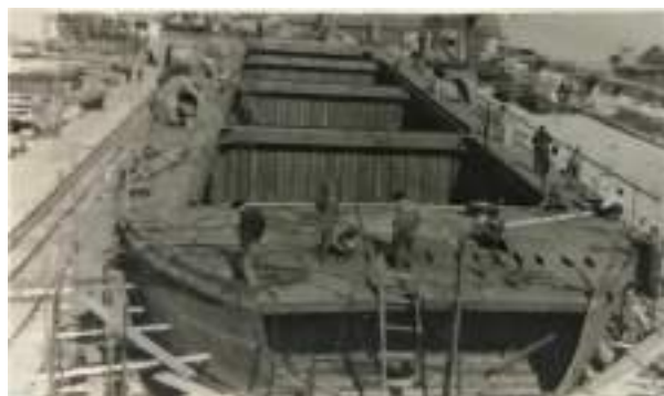
MOTONAVA DE 2000 DE TONE In construcţie pe cală şi la lansare Seria de nave a cuprins 22 de unităţi
