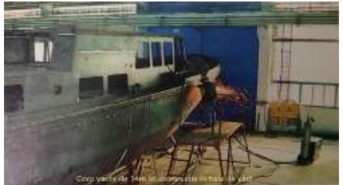
Coșul yachtului de 14m în procesul de construcție în hala de yachting
