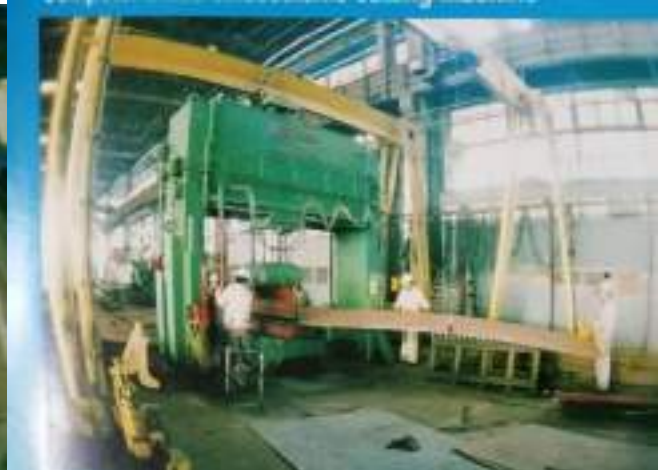
Presa de fasonat table de 350 tf
